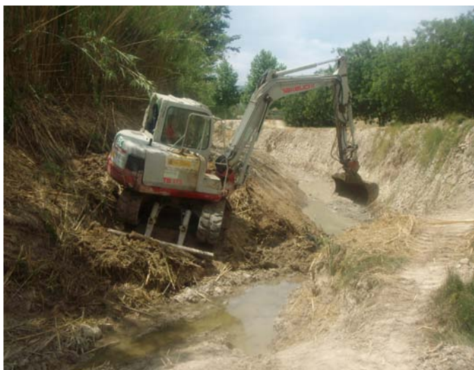
Imagen tomada durante los trabajos de perfilado de taludes.
