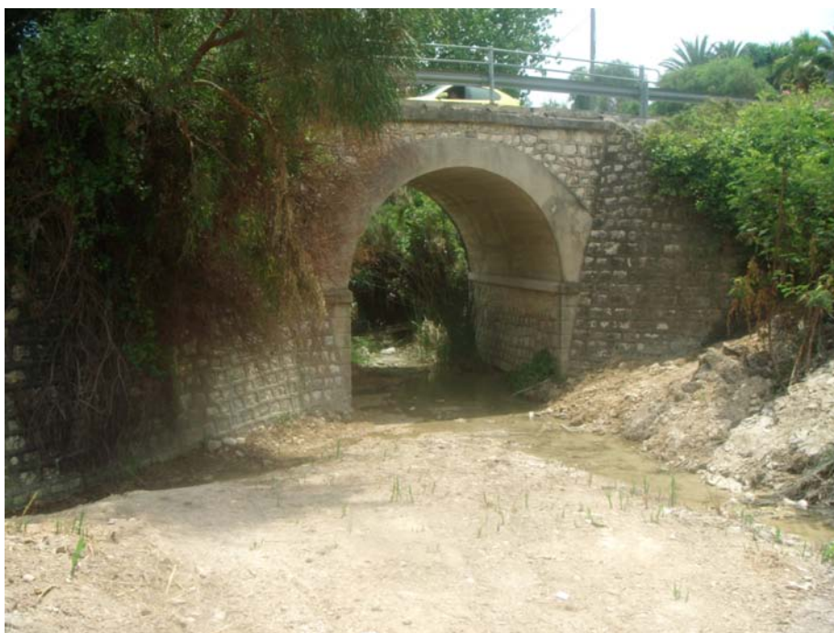
Paso bajo el puente tras los trabajos de limpieza.
