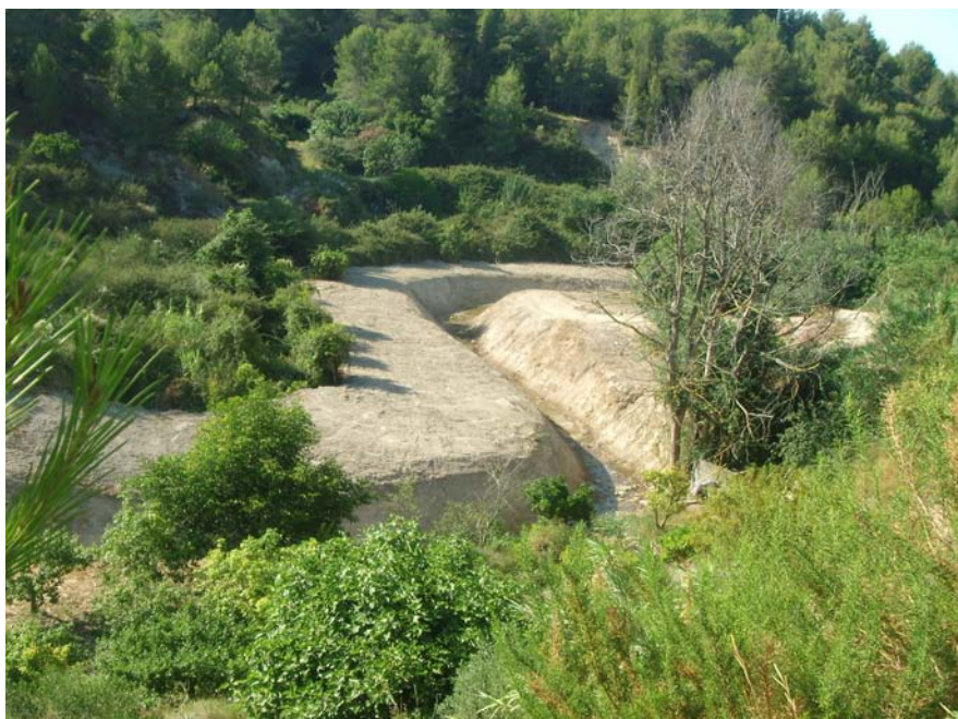
Vistas comparativas de las obras llevadas a cabo en el Bco. de Santa Ana.
