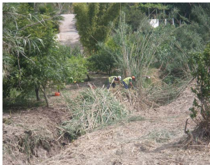
Trabajos manuales de corte y retirada de vegetación obstructiva.
