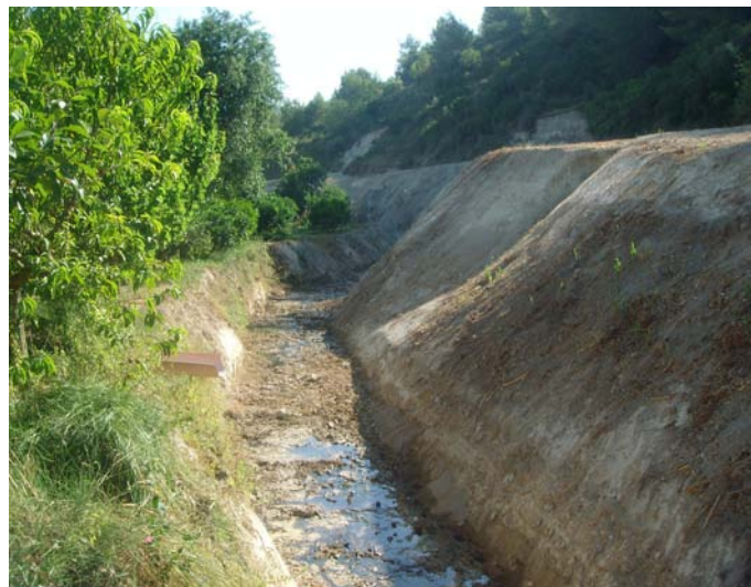
Vistas comparativas de los trabajos. EL desnivel de la margen izquierda del tramo de las imágenes obligó a realizar banquetas de trabajo a media altura del talud.
