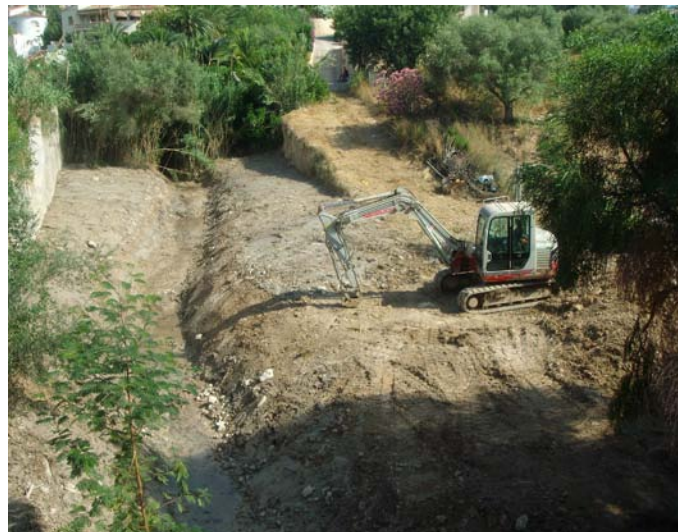
Imagen del mismo punto tomada durante los trabajos.
