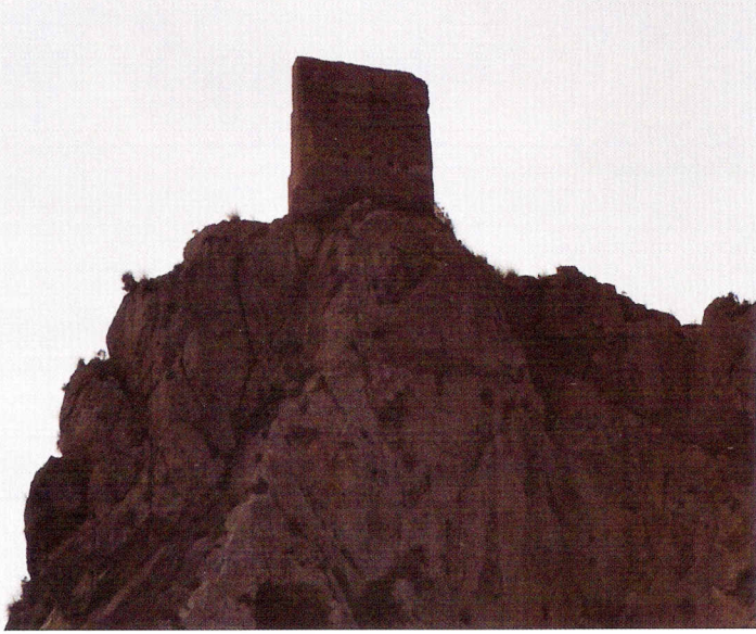
Figs. 3: Mur del Castellet del Mascarat. Foto des de l'est feta abans de la seua consolidació. (Font: LLOPIS BERTOMEU, 1953)
