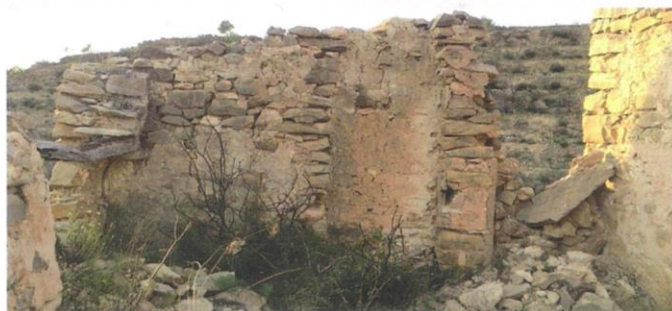
Foto 5: Detall d'una murada de la casa i l'adossament al cos central. La paret d'aquest (a la dreta de la imatge) no enllaça directament amb el possible riu-rau, tractant-se per tant d'un afegit posterior més o menys coetani.
