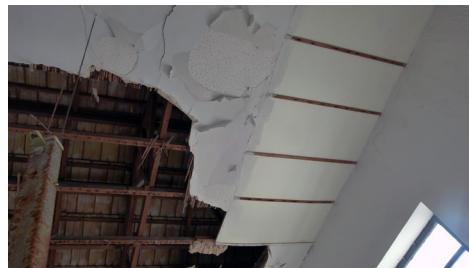
Ilustración 207, Techo de cañizo junto con placas de corcho
