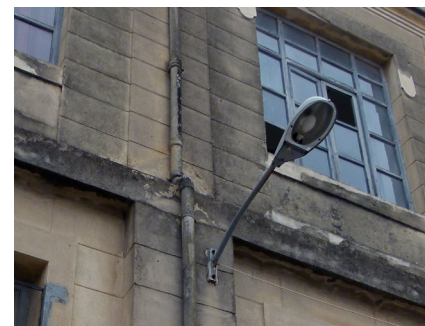
Ilustración 240, Farola anclada en muro de fachada
