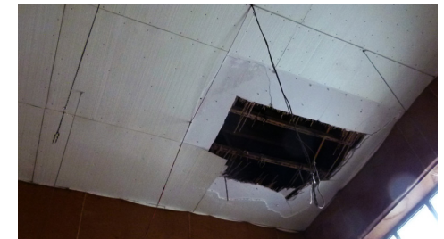
Ilustración 209, Techo de placas de corcho sobre cañizo
