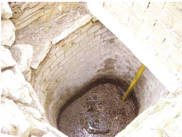
Fig. 3: Sénia del Molí del Quisi, ja abandonada, que degué funcionar al final amb el sistema de la bomba hidràulica.
