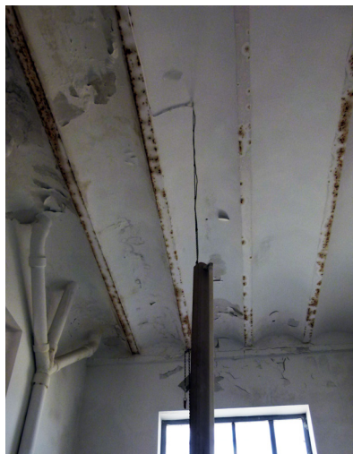
Ilustración 173, Forjado de viguetas
