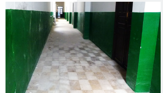
Ilustración 183, Zócalo de pintura color verde en pasillo de planta baja
