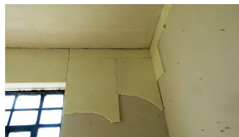
Ilustración 188, Placas de corcho en pared
