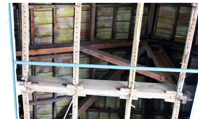
Ilustración 177, Cubierta de cerchas de
