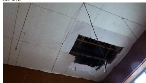
Ilustración 209, Techo de placas de corcho sobre cañizo
