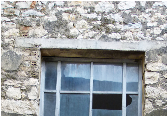
Ilustración 167, Dintel de cemento armado
