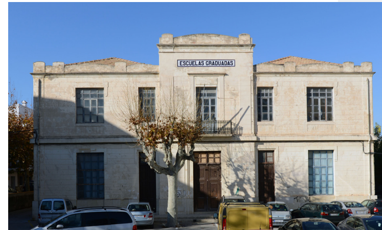
Ilustración 99, Fachada Principal, Año 2013
