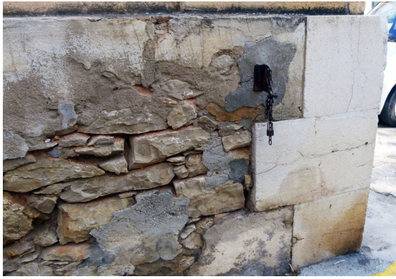
Ilustración 166, muro de mampostería y zócalo de sillería
