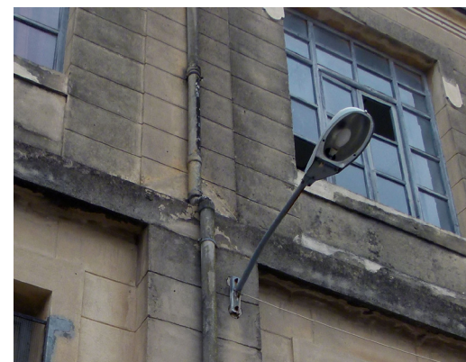
Ilustración 240, Farola anclada en muro de fachada
