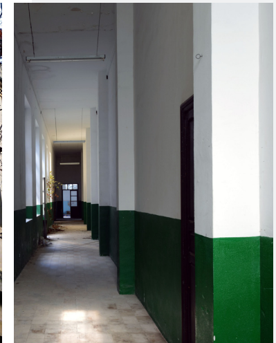
Ilustración 154, Correa perimetral Ilustración 155, Pilares Planta Baja
