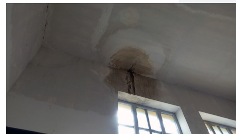
Ilustración 208, Falso techo de cañizo suspendido
