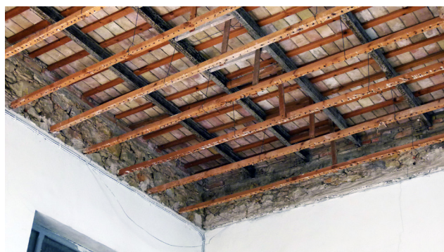
Ilustración 176, Cubierta a la catalana
