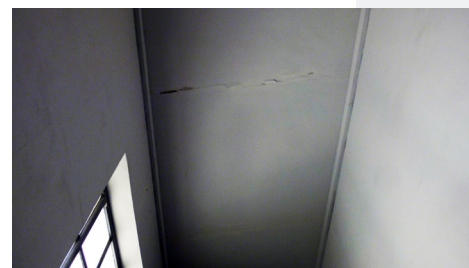
Ilustración 210, Techo de escayola
