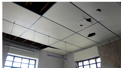
Ilustración 211, Techo de placas de corcho
