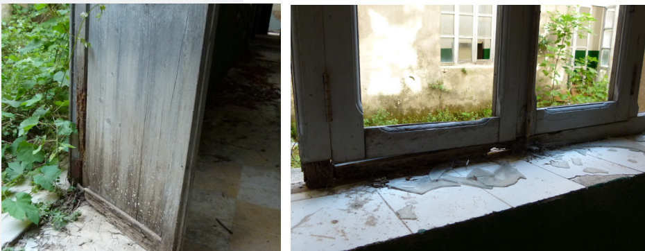
Ilustraciones 215,216, carpintería en patio
