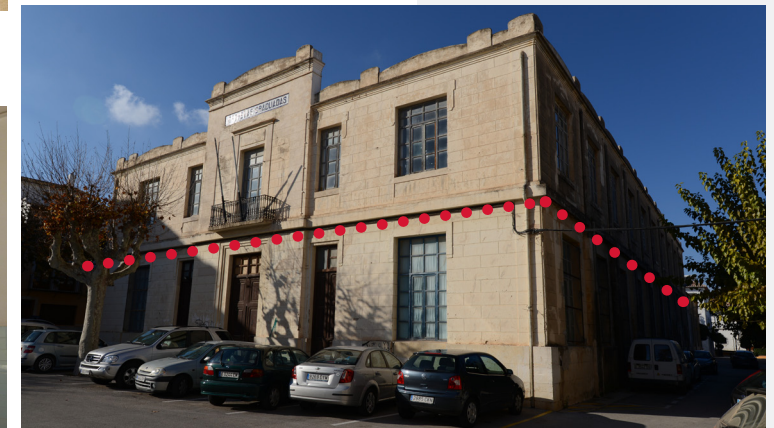
Ilustración 118, Correa perimetral en el exterior
