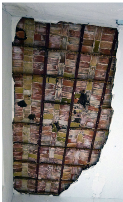
Ilustración 174, Forjado de ladrillo
