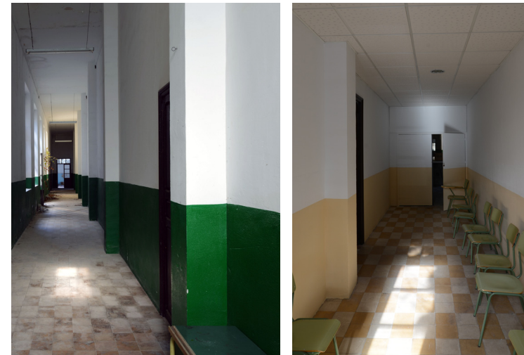
Ilustraciones 164,165, Pilares de ladrillo en Planta Baja
