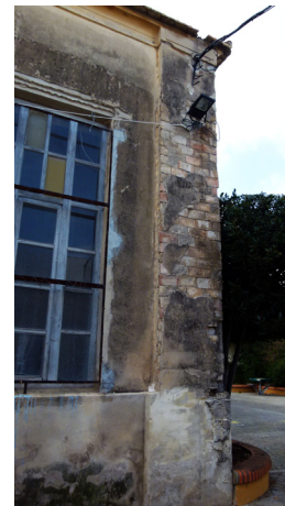
Ilustración 171, Pilastra de ladrillo
