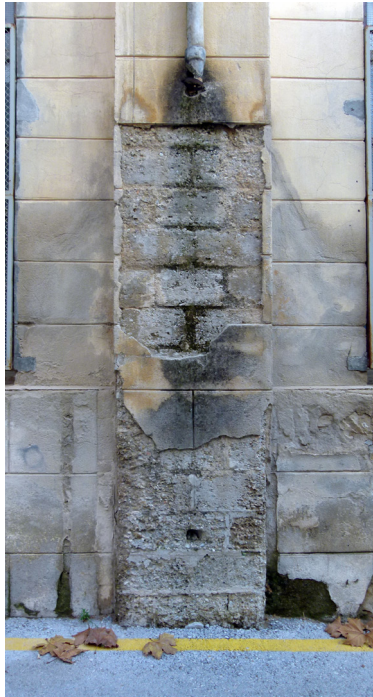
Ilustración 169, Pilastra de sillería artificial
