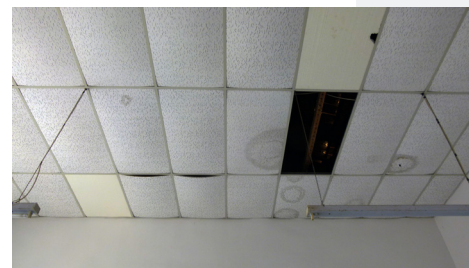
Ilustración 212, Techo de placas de corcho
