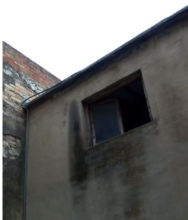
Ilustración 170, Muro de bloques de hormigón
