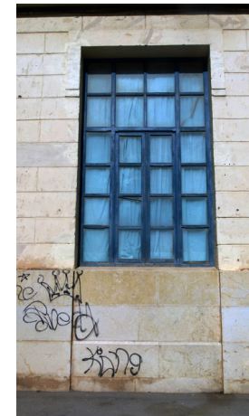
Ilustración 172, Repisa ventana ladrillo
