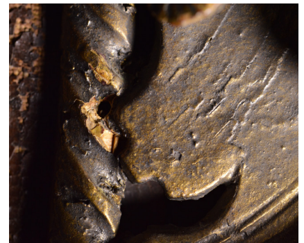
Imagen 53: Detalle del ennegrecimiento del marco ocasionado por una corla.
