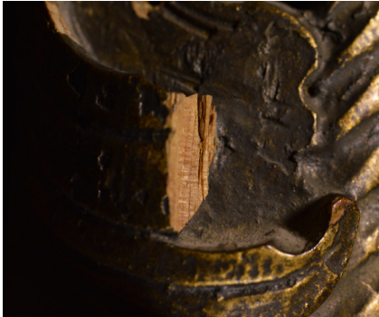
Imagen 54: Detalle del marco y los faltantes del soporte l gneo, as  como la acumulaci n de polvo en algunas zonas.
