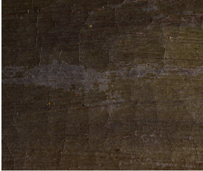
Imagen 48: Detalle de los pasmos en la superficie.
