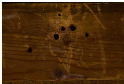
Imagen 28: Fotografía de detalle de agujeros e incisiones en el listón superior del bastidor.
