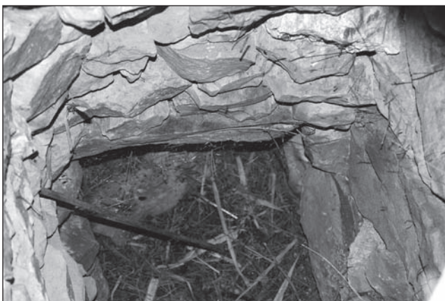
Làmina VII. Canalització subterrània, que passa per sota del pouet 1.
