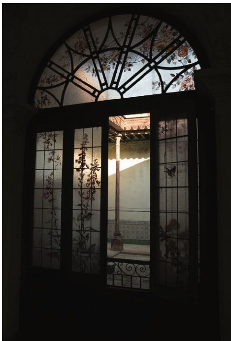
Figura 8. Vista desde la galería hacia el patio central. Fuente: © Néstor Martí.
