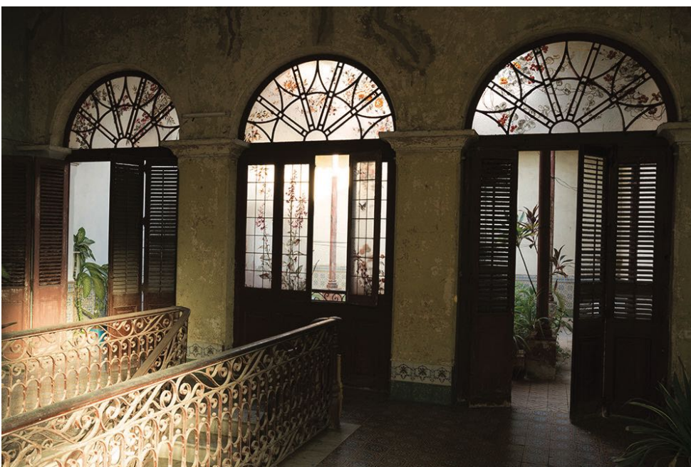
Figura 10. Serie de arcos de medio punto que enlazan con las galerías que rodean.
